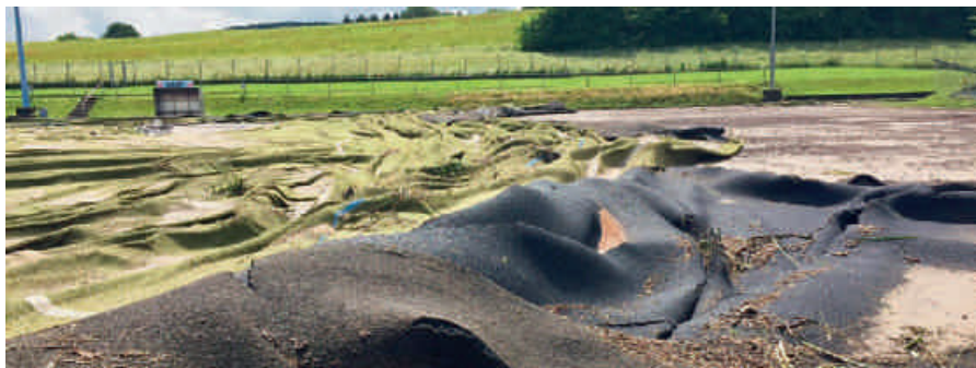
Der Bliesransbacher Sportplatz am Tag nach dem Unwetter
