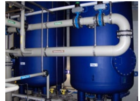
Neue Filterkessel im Hochbehälter Kappelberg
