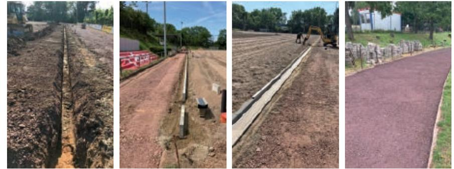
Nun war in den Tagen danach die Entwässerung mit der entsprechenden Dränage an der Reihe. Zunächst einmal die Sammlerdränage rund um den Platz zwischen Rasenplatz und Laufbahn in einer Tiefe zwischen 44 cm und 120 cm. Das Wasser läuft dabei jeweils von der Höhe der Mittellinie zu den Eckfahnen und von dort zur Mitte des Platzes hinter den Toren in einen Schacht. Gleichzeitig wurde ein Spül- und Kontrollschacht angelegt.
